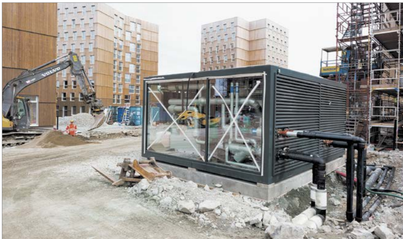
Fot. 5. Montaż przeszklonej maszynowni w centrum miasteczka studenckiego – pełni ona także funkcję edukacyjną Fot. afgruppen.no
