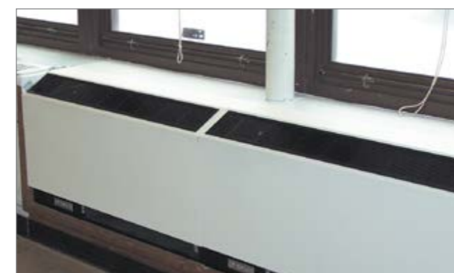
Fot. 2. Bosch CA – pompa ciepła zaprojektowana tak, aby zapewnić ogrzewanie i chłodzenie w miejscach, gdzie przestrzeń i dostęp są ograniczone. Wykorzystywana jako zdecentralizowana jednostka końcowa w budynkach szkolnych, biurowych i mieszkalnych oraz hotelach Fot. Bosch Thermotechnology Corp.
