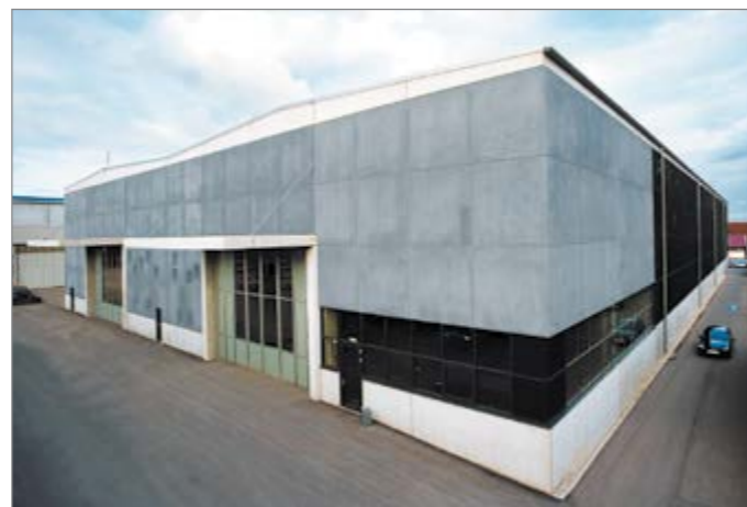
Fot. 3. Widok hali produkcyjnej Laumer Bautechnik ze ścianami prefabrykowanymi wyposażonymi w instalacje do pozyskiwania ciepła promieniowania słonecznego Fot. Laumer Bautechnik
