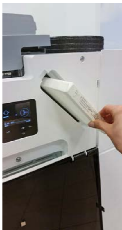
Wymiana filtrów w rekuperatorze
