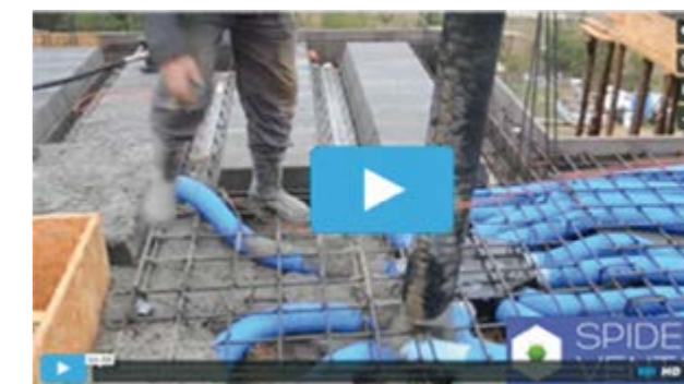
SPIDERvent w stropie typu Teriva
