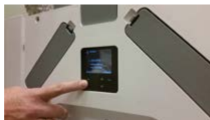
Sterowanie rekuperatorem z poziomu wyświetlacza
