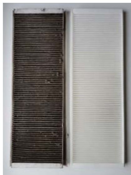
Brudny (po lewej) i czysty filtr z rekuperatora
