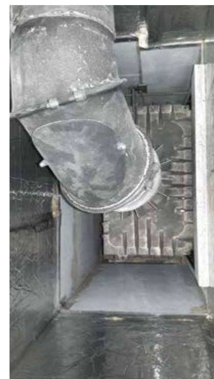
Rys. 4. Pokryty kurzem wkład kominkowy i przewód kominowy w kominku A
