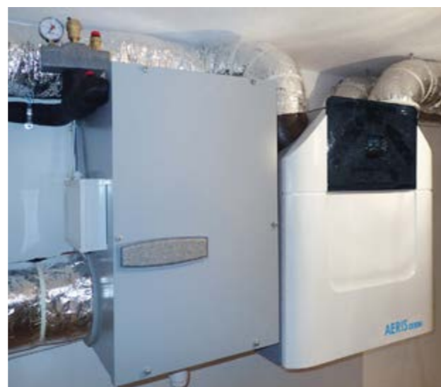
GWC z rekuperatorem AERISnext – montaż pod sufitem
