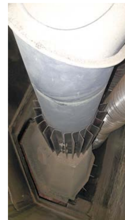
Rys. 5. Pokryty kurzem wkład kominkowy i przewód kominowy w kominku B
