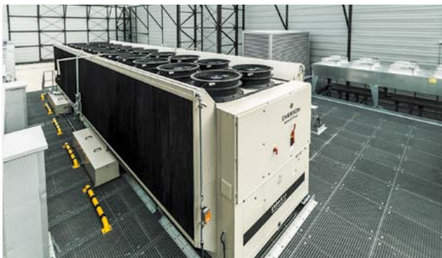
Dach centrum danych Data Centre 2 firmy Beyond.pl (Poznań). Zastosowano opatentowany agregat adiabatyiczny firmy Vertiv (d. Emerson) mat. Beyond.pl
