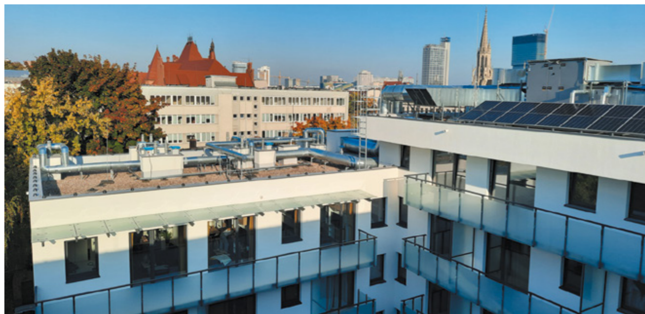
Fot. 2. Fragment dachu budynku z instalacją paneli PV oraz instalacją zasilającą układ wentylacji
