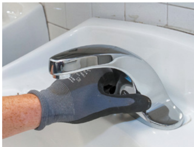
Fot. 1. Umywalkowa bateria bezdotykowa zapewniająca strumień wody o wielkości 1,3 l/min podczas montażu i regulacji w pomieszczeniach Uniwersytetu Południowej Kalifornii w Los Angeles. Źródło: Chicago Faucets, [4]
