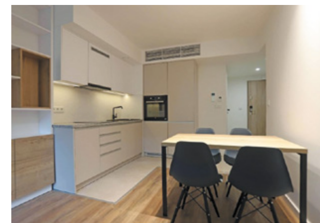
Fot. 3. Aneks kuchenny z modułem indukcyjnym grzewczo-chłodzącym zamontowanym pod sufitem
