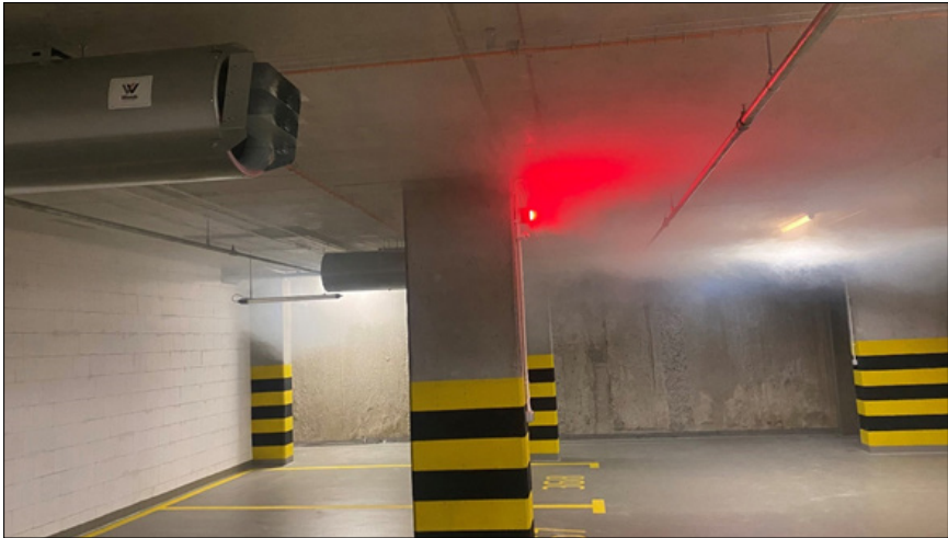
Fot. 3. Ukierunkowanie gorącego dymu przez wentylatory strumieniowe
