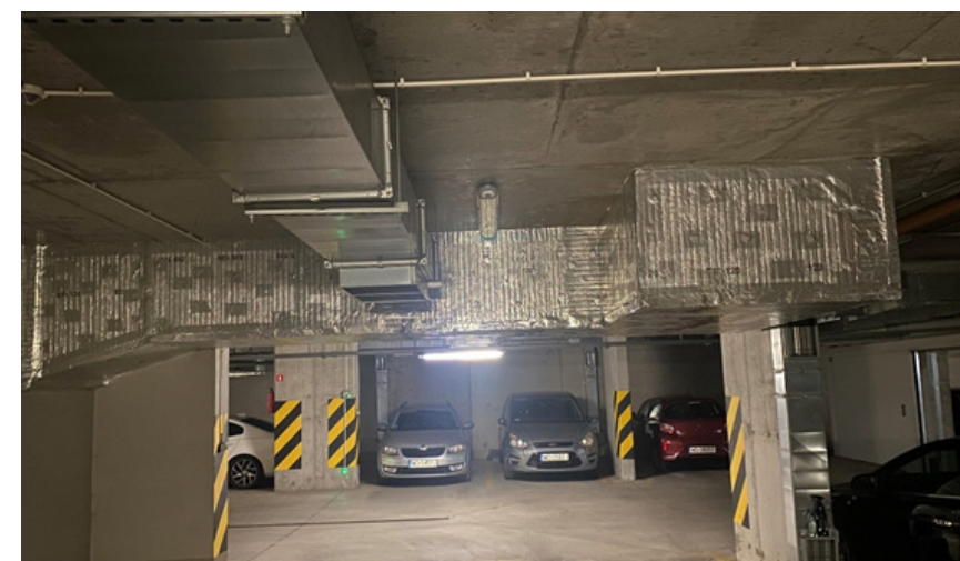
Fot. 2. Kanał oddymiający w izolacji systemu CONLIT o klasie odporności EIS 120
