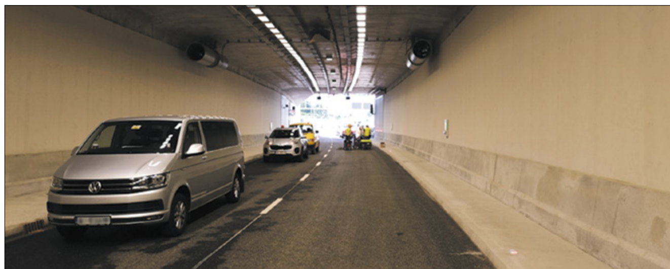
Fot. 6. Portal wjazdowy do nawy tunelu drogowego – oddymianie przeciwne do kierunku poruszania się samochodów daje najlepsze efekty
