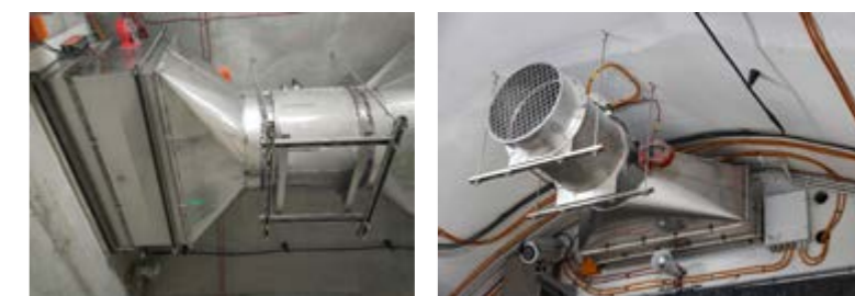
Rys. 5. Jednostka napowietrzająca w wykonaniu nierdzewnym, montaż pod stropem
