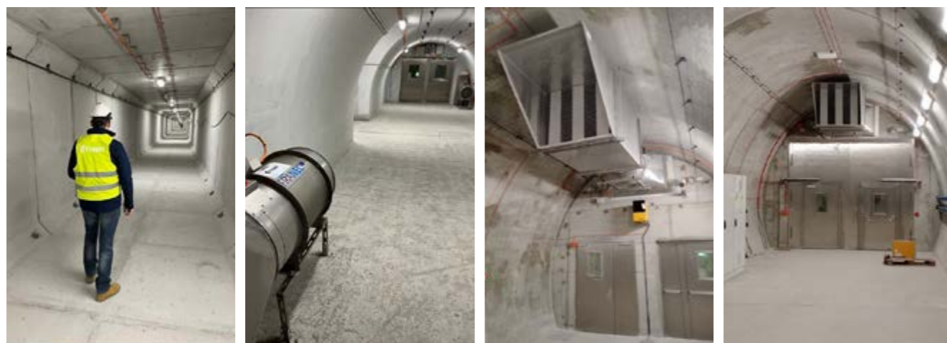
Rys. 1. Przejście i przejazdy ewakuacyjne
