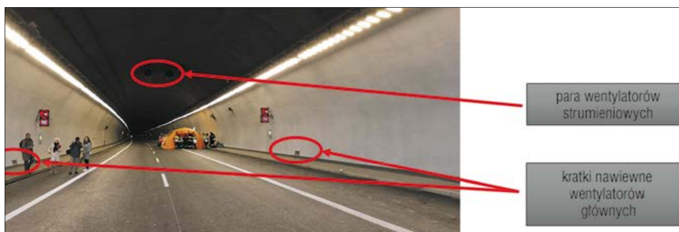
Fot. 3. Widok tunelu z nawiewem od dołu i rewersyjnymi wentylatorami strumieniowymi Źródło: Neuron
