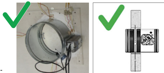
Prawidłowe umieszczenie klapy w stropościanie
