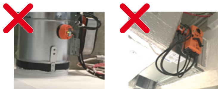
Prawidłowe umieszczenie klapy w stropościanie
