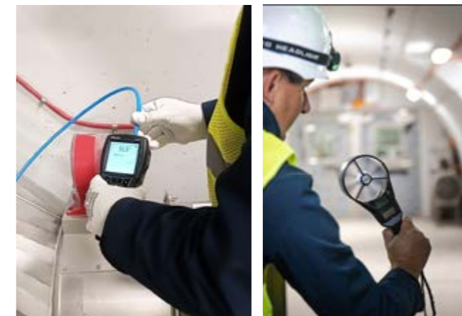
Rys. 4. Pomiar prędkości na otwartych drzwiach i zadanej różnicy ciśnień
