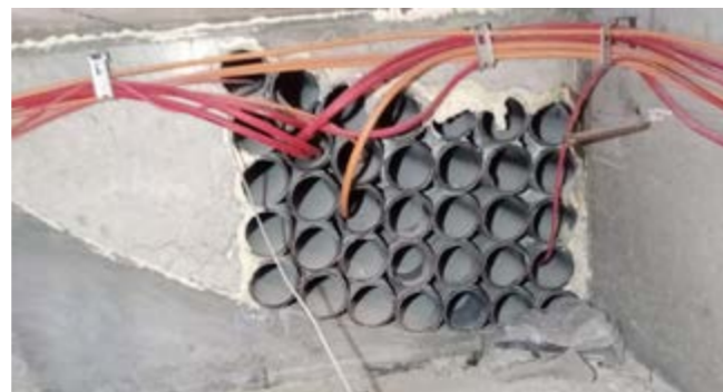
Rys. 2. Przygotowane przepusty technologiczne
