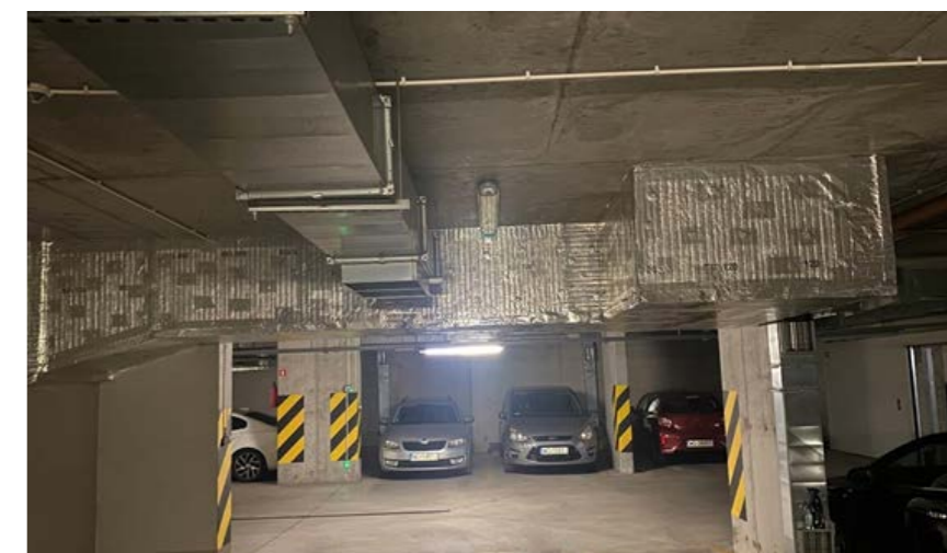
Fot. 2. Kanał oddymiający w izolacji systemu CONLIT o klasie odporności EIS 120 Źródło: arch. autora
