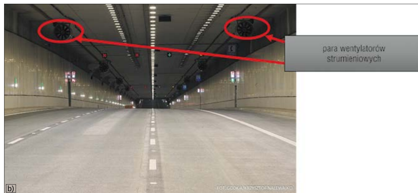
Fot. 2. Widok tunelu: a) zaznaczone kraty nawiewne i wyciągowe, b) para wentylatorów strumieniowych Źródło: Neuron
