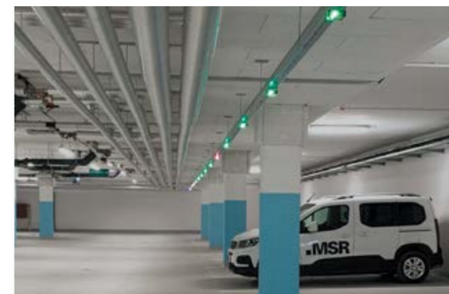
Fot. 3. Przykładowy system MSR-Traffic połączony z systemem detekcji gazów MSR-Electronic Źródło: archiwum autora
