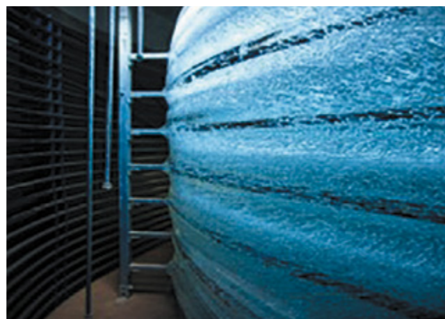
Rys. 5. Magazyn energii w lodzie Źródło: archiwum autora
