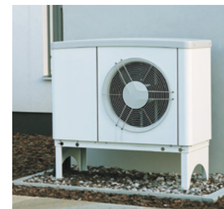
Fot. 3. Odprowadzenie skropliny z pompy ciepła do gruntu wymaga zapewnienia warstwy przepuszczalnej Źródło: Adobe Stock
