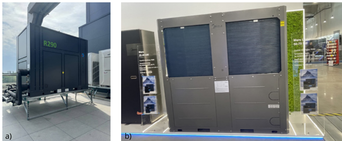
Fot. 1. Większe pompy ciepła na czynnik chłodniczy R90: a) do przemysłu lekkiego, b) komercyjna – premiera na targach Warsaw HVAC Expo 2025 Źródło: Midea/arch. redakcji
