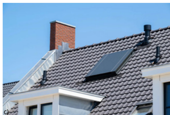
Fot. 1. HydroTop – system obudowy pompy ciepła do montażu w dachu ze spadem: a) wkładanie urządzenia od zewnątrz; b) stan po zamontowaniu; c) widok dachu po zakończeniu prac dekarских. Źródło: Dutch Heat Pump Solutions
