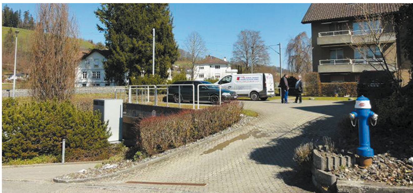
Fot. 4. Pompa ciepła przy wjeździe do garażu podziemnego – odpowiednia odległość od budynków zapewnia spełnienie wymagań akustycznych także dla urządzeń o dużej mocy [10]
