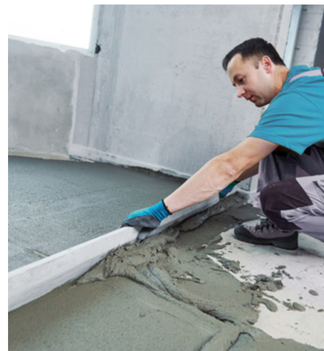
Aplikacja posadzki cementowej TectorFloor. Gwarancja idealnie równego podłoża pod każdy rodzaj wykończenia
