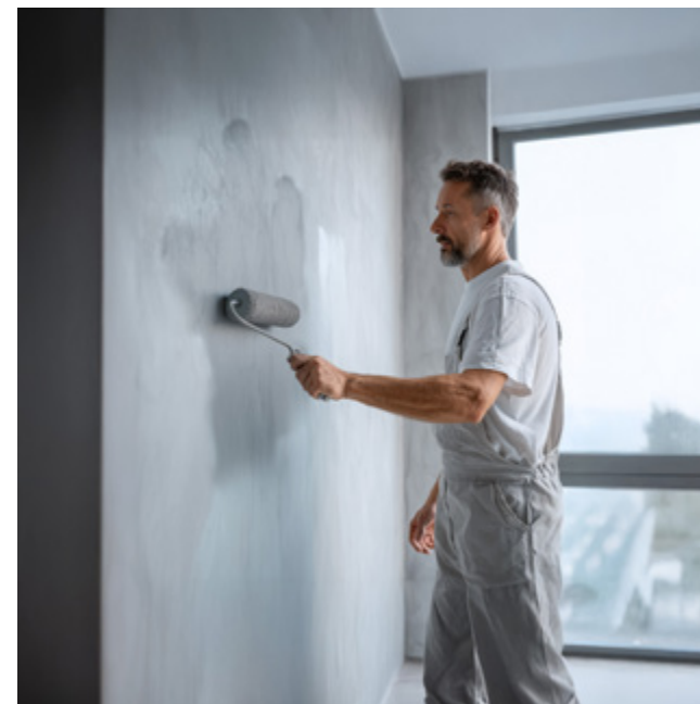
Aplikacja gruntu TectorSpex zapewnia lepszą przyczepność i stabilność podłoża
