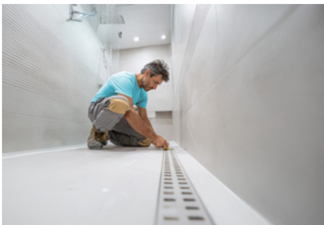
Prawidłowe osadzenie odpływu liniowego – kluczowy etap przygotowania posadzki prysznicowej
