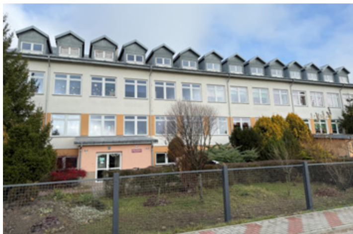
Fot. 2. Szkoła Podstawowa im. Tadeusza Kościuszki w Brzeźnie (woj. lubelskie) ze zmodernizowaną kotłownią
