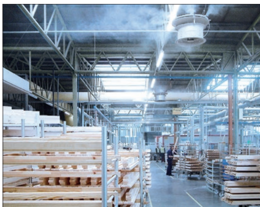
Fot. 3. Powietrze w zakładzie przemysłowym może wymagać dodatkowego nawilżenia, np. w przetwórstwie drewna. Na zdjęciu zakład produkujący m.in. okna drewniane z systemem wysokociśnieniowego nawilżania Źródło: Condair
