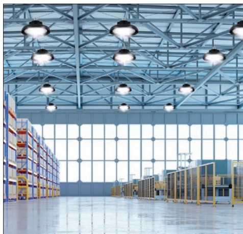
Fot. 2. Wymiana systemu oświetleniowego na nowoczesne oprawy LED typu „High Bay” to jeden ze skutecznych sposobów na zauważalną poprawę efektywności energetycznej (dotyczy to także wymiany starszych źródeł LED na nowsze) Źródło: LedHoff
