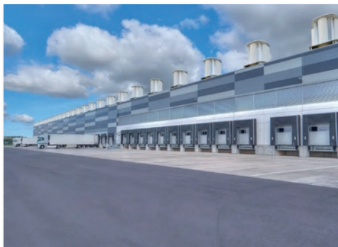
Fot. 5. Dachowe turbiny wiatrowe dla budynku magazynowo-logistycznego (rozwiązanie amerykańskie) Źródło: Aeromine
