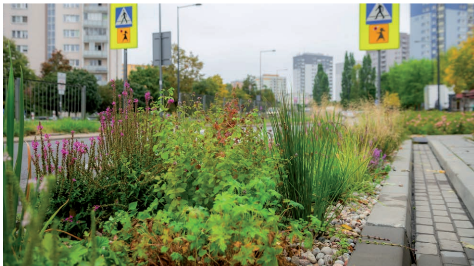
Fot. Ogród deszczowy w formie pasa zieleni przy jezdni
