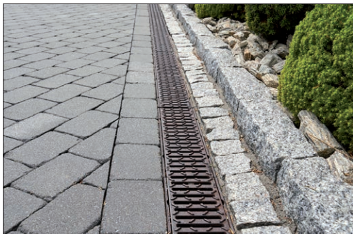
Fot. 2. Odwodnienie liniowe: a) zamontowane betonowe z metalowym rusztem do odwadniania drogi
