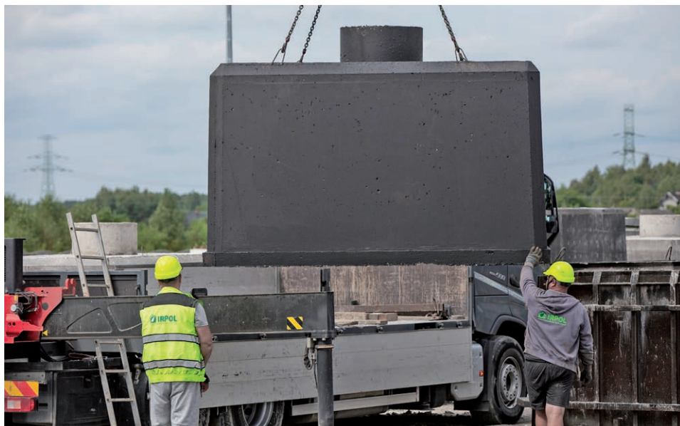
Fot. 3. Załadunek do transportu betonowego zbiornika na deszczówkę, wodę klasy Super Premium MONOLITH na placu produkcyjnym firmy Irpol
