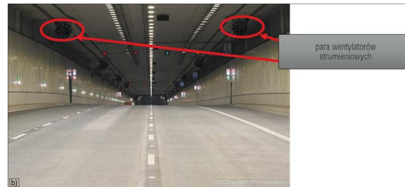
Fot. 2. Widok tunelu: a) zaznaczone kraty nawiewne i wyciągowe, b) para wentylatorów strumieniowych
