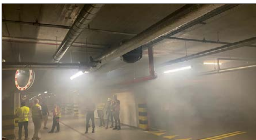
Fot. 4. Zadymienie podczas próby z gorącym dymem przed uruchomieniem systemu oddymiania wentylacji strumieniowej Źródło: arch. autora
